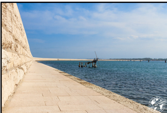
La diga che porta verso Cà Roman
